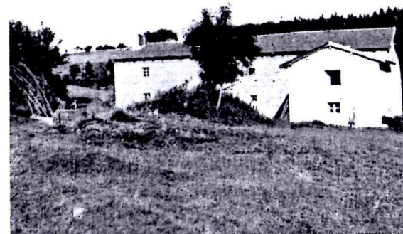
UNE JASSERIE RECONSTRUITE
