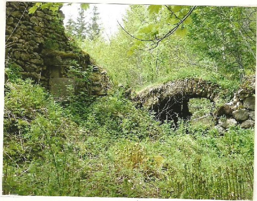
ruines de cave et pignon
