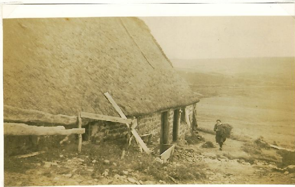
protection de la toiture
